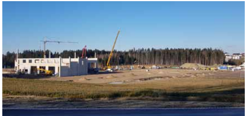
Fa. Biohort - Die Bauarbeiten schreiten in großen Schritten voran.
